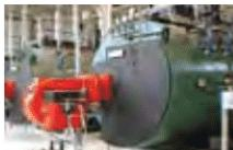
Hemikalije za tretman kotlovske vode održavaju unutrašnjost kotla čistom i minimiziraju uslove za pojavu korozije – smanjuju pregrevanje površina i oštećenja na njima. Kontrola korozije i depozita povećava pouzdanost u radu i štiti opremu, smanjujući troškove održavanja i potrošnju goriva. Neke hemikalije dodatno smanjuju i mogućnost odnošenja vode parom na taj način štiteći grejače i turbine za paru od oštećenja.
